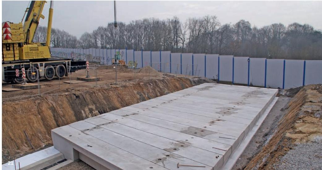
**Abb. 21:** Sicherung des Isabella-Stollens mit Fertigbauteilen, 2016. (J. Habich)
