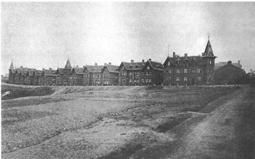
Abb. 9: Der „Außenring“ der zweiten Hüttenarbeiterkolonie des Bochumer Vereins an der Wörthstraße, der heutigen Ursulastraße, um 1895. Am rechten Bildrand verläuft die Bessemerstraße.
