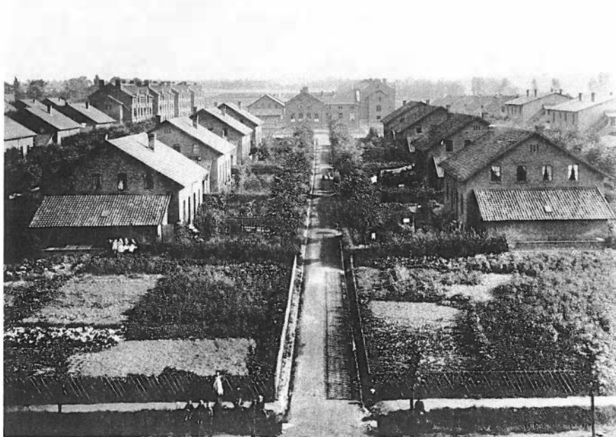
Abb. 6: Blick auf die Kolonie vom Dach der Kanonenwerkstatt an der Alleestraße im Jahr 1884. In der Achse der Mittelstraße lag auf einem zentralen Platz die im gleichen Jahr eröffnete Kleinkinderbewahranstalt.
