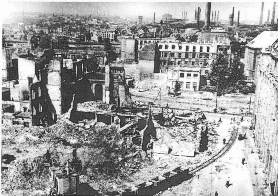
Abb. 7: Rund 109.000 m<sup>3</sup> Trümmerschutt seien bis Ende 1945 weggeräumt worden, berichtete Dr. Geyer in der neuen Stadtvertretung am 28. Januar 1946. Welche Ausmaße die Trümmerbeseitigung hatte, zeigt dieses erst 1948 entstandene Bild des Bereiches Harmonie-/Kortumstraße.
