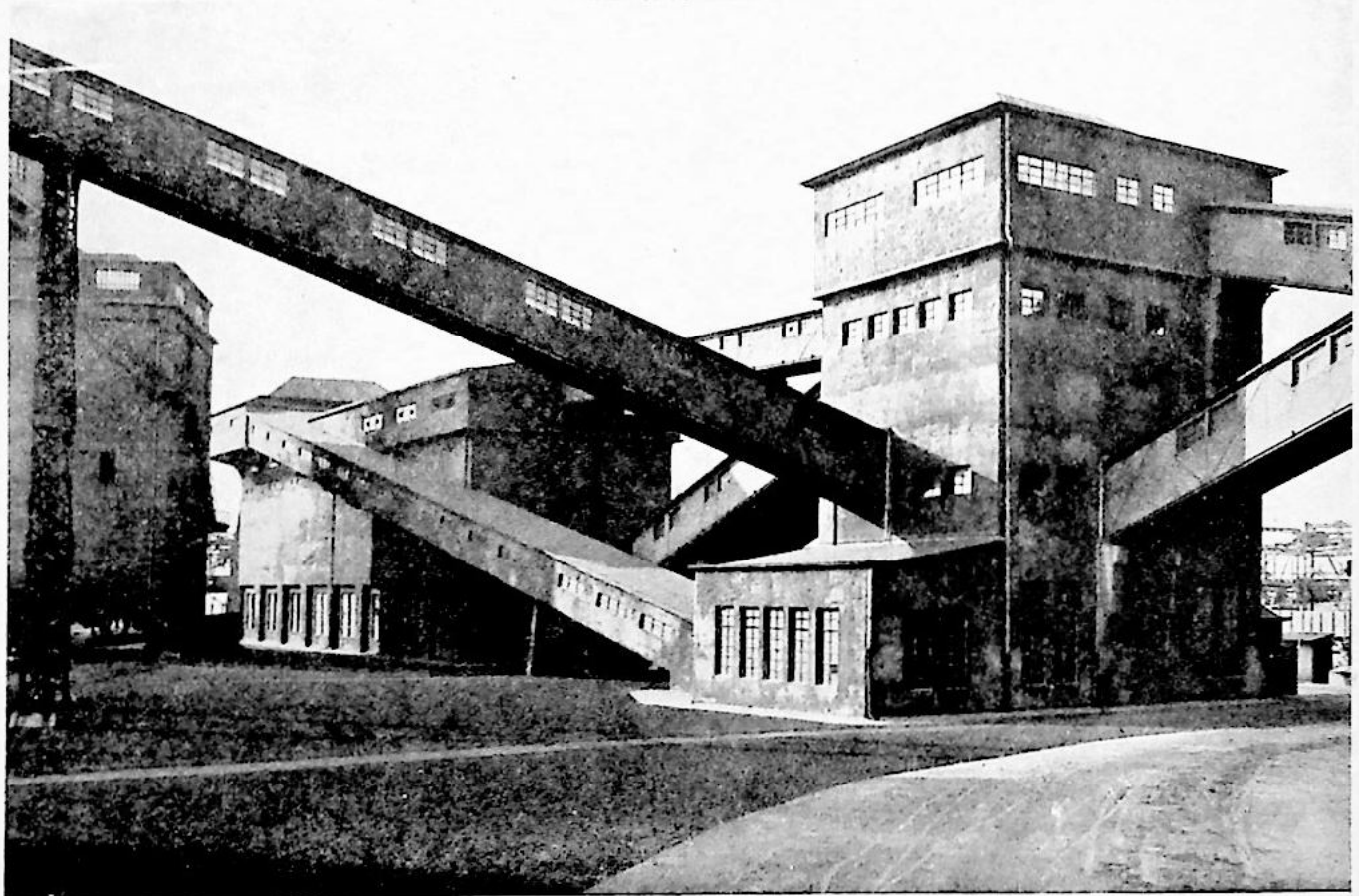
Burgtürme von heute: Kohlenmischanlage mit Transportbandbrücken auf der Zeche „Karolinenglück“
