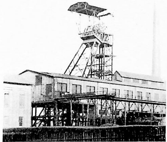
Abb. 6 Aufn. d. Werk Seilscheibengerüst der Zeche „Constantin der Große“, Schacht IIa
