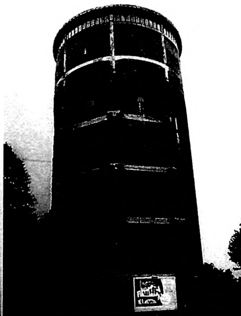
Wasserturm des Werks Höntrop
