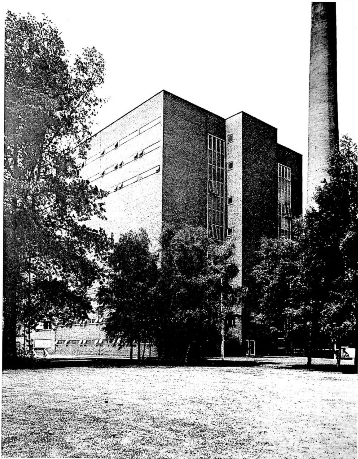
Kraftwerk Prinz Regent, Kesselhaus von 1962 Photo: Stefan Kuhn
