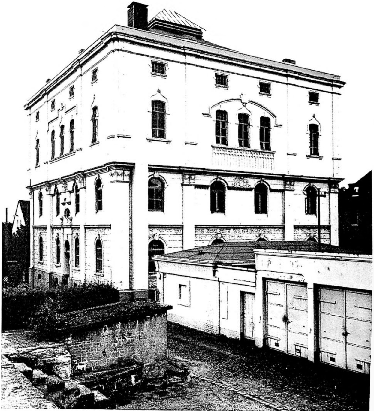
Wasserturm Hattinger Straße, Rückansicht Photo: Stefan Kuhn
