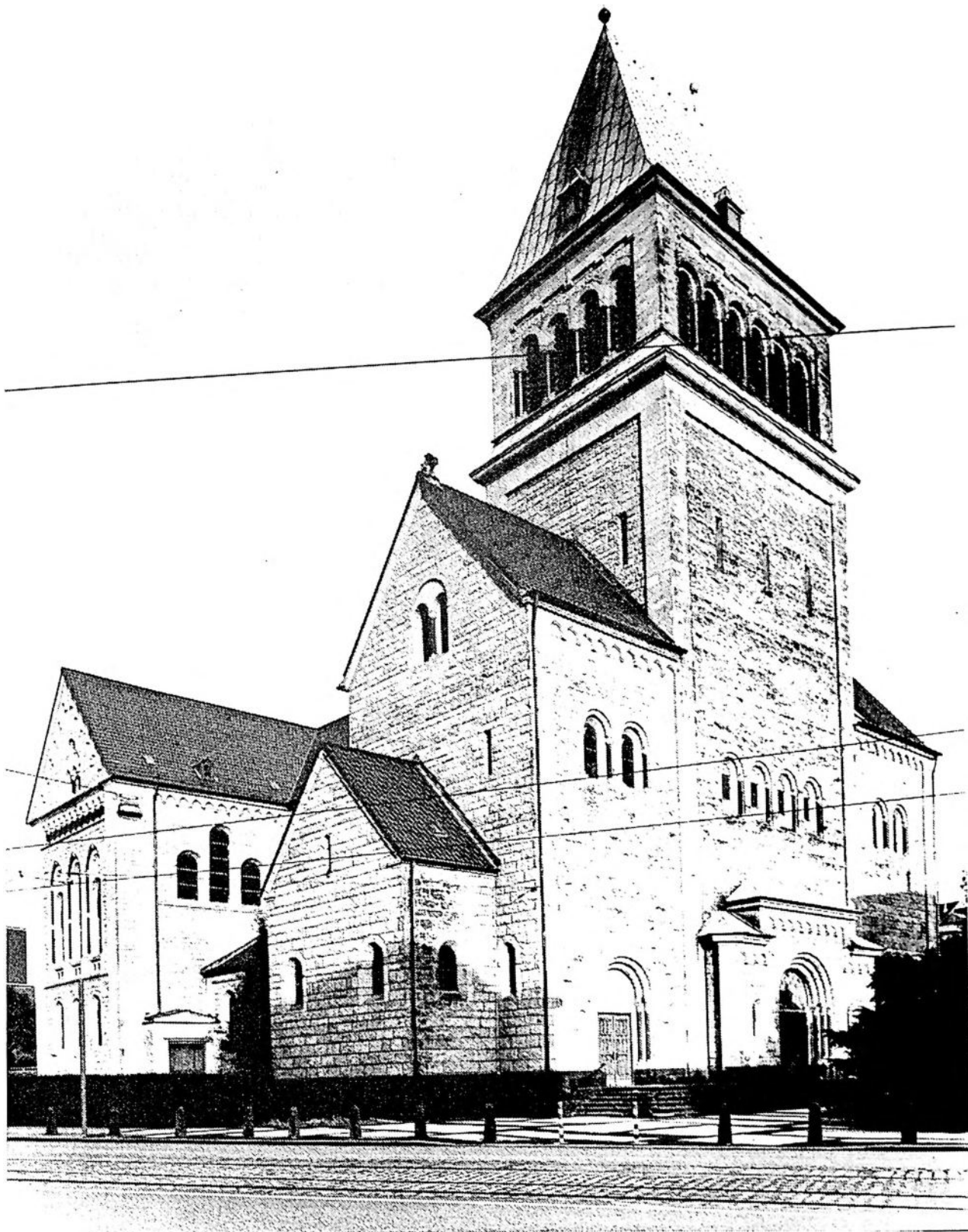
St. Meinolphus-Kirche, Nord- und Westfassade Photo: Stefan Kuhn
